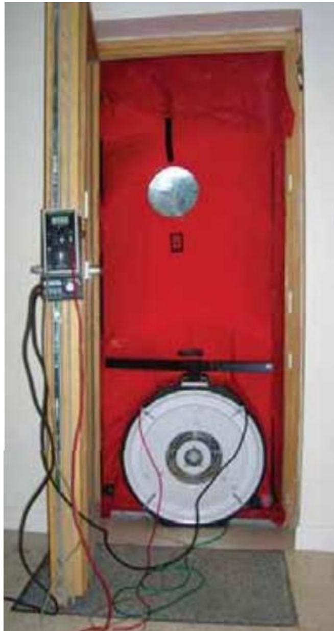
Blower door testing
